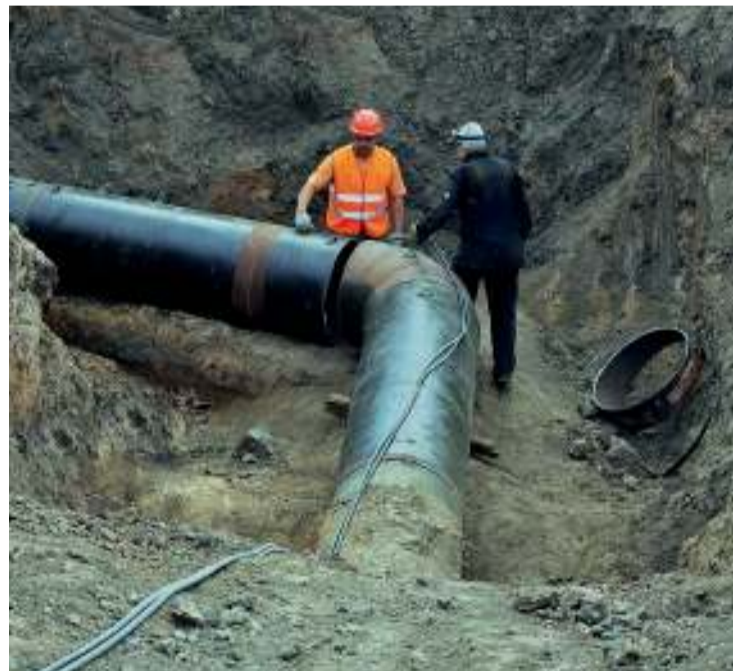
Во время ремонта на водоводе обновили участок поворота
